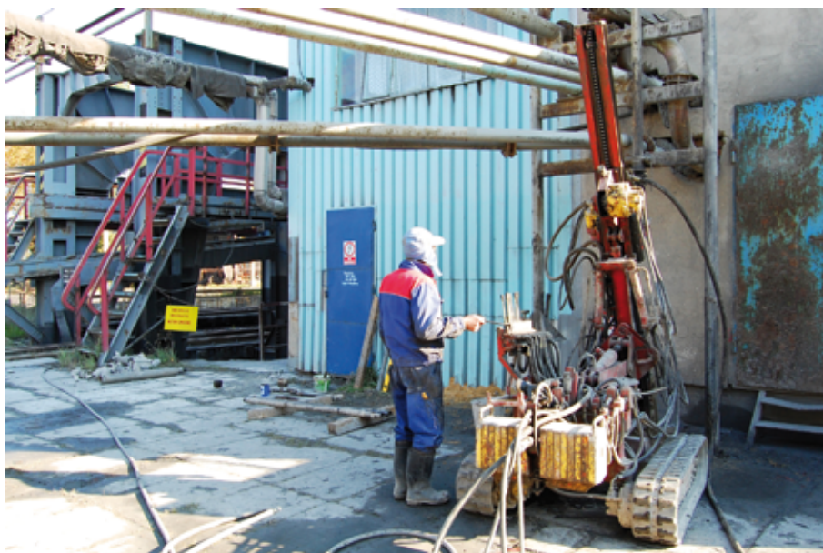
Rys. 4. Formowanie kolumn iniekcyjnych do wzmocnienia posadowienia wieży szybowej szybu „Podszkowego” w kopalni „Marcel”
