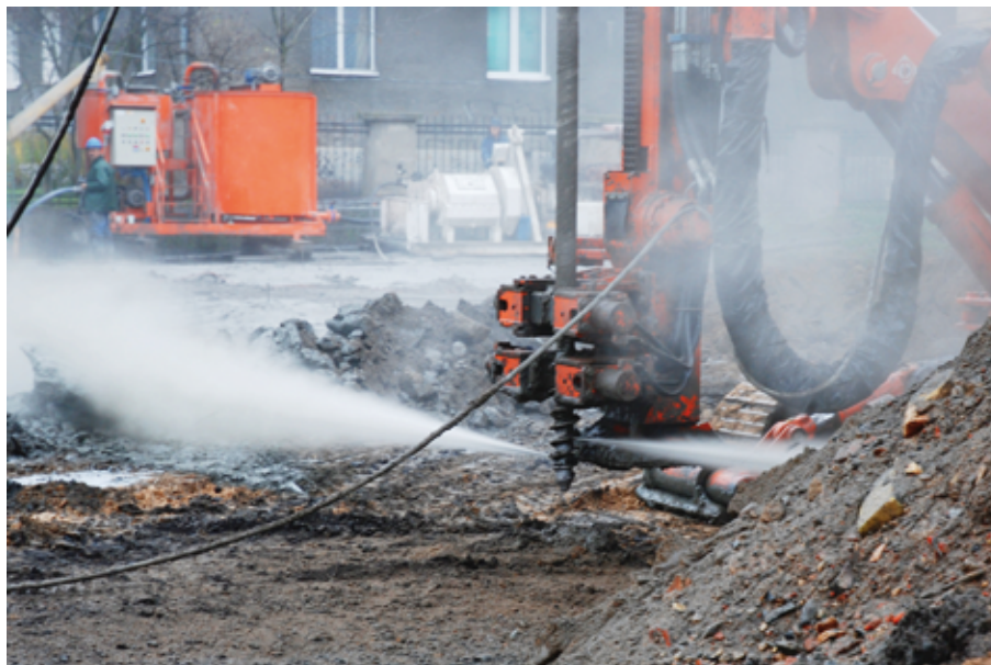
Rys. 1. Strumień iniektu formujący kolumnę „jet grouting”.
